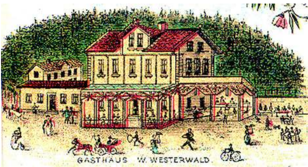
Auch nach Erbauung des Wohnhauses wurde das rechts daneben befindliche „Zelt“ noch als Gaststätte genutzt.
