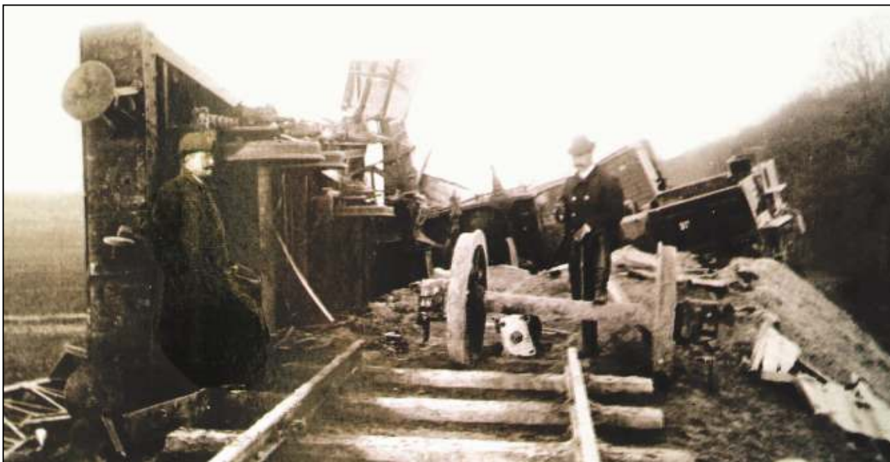
Am 14.11.1901 verunglückte durch einen Erdrutsch diese Lok zwischen Remlingen und Wittmar.
