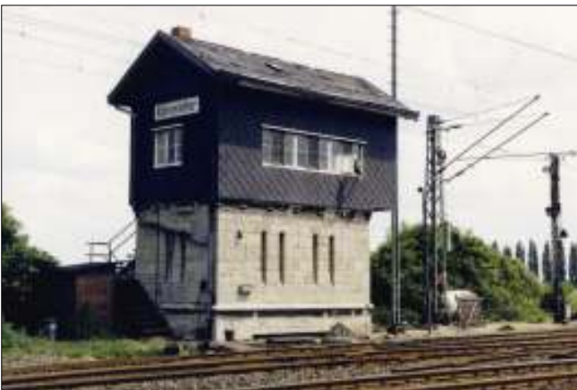
Das ehemalige Stellwerk Kw
